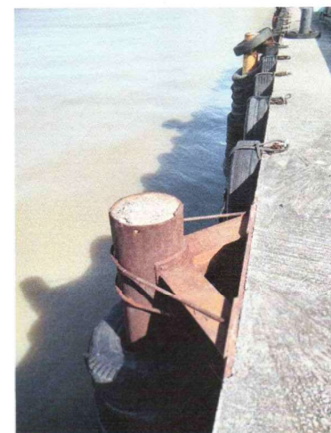
ภาพแสดง หน้าทำที่แข็งแรงไม่มีรอยแตกร้าว ไม่ทรุดเอียง
