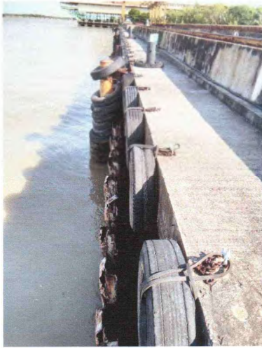
ภาพแสดง หน้าท่าที่แข็งแรงไม่มีรอยแตกร้าว ไม่ทรุดเอียง
